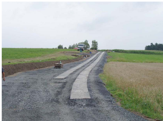
Výstavba kolejové polní cesty
